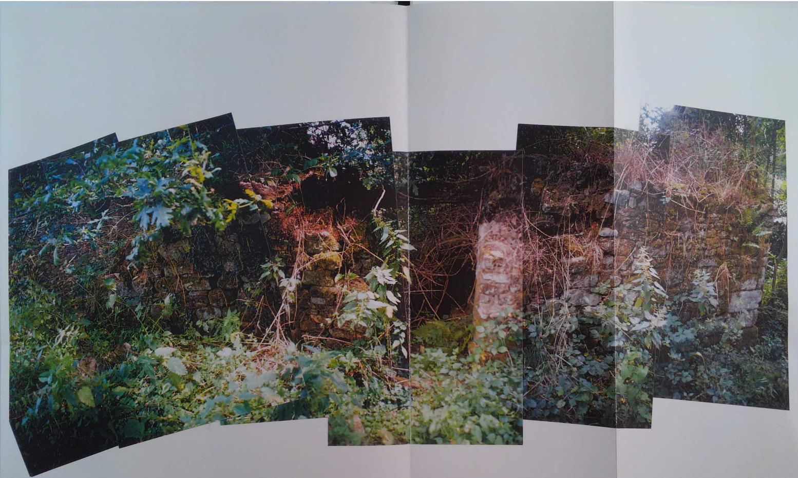
Maçonnerie du mur Nord-Ouest
