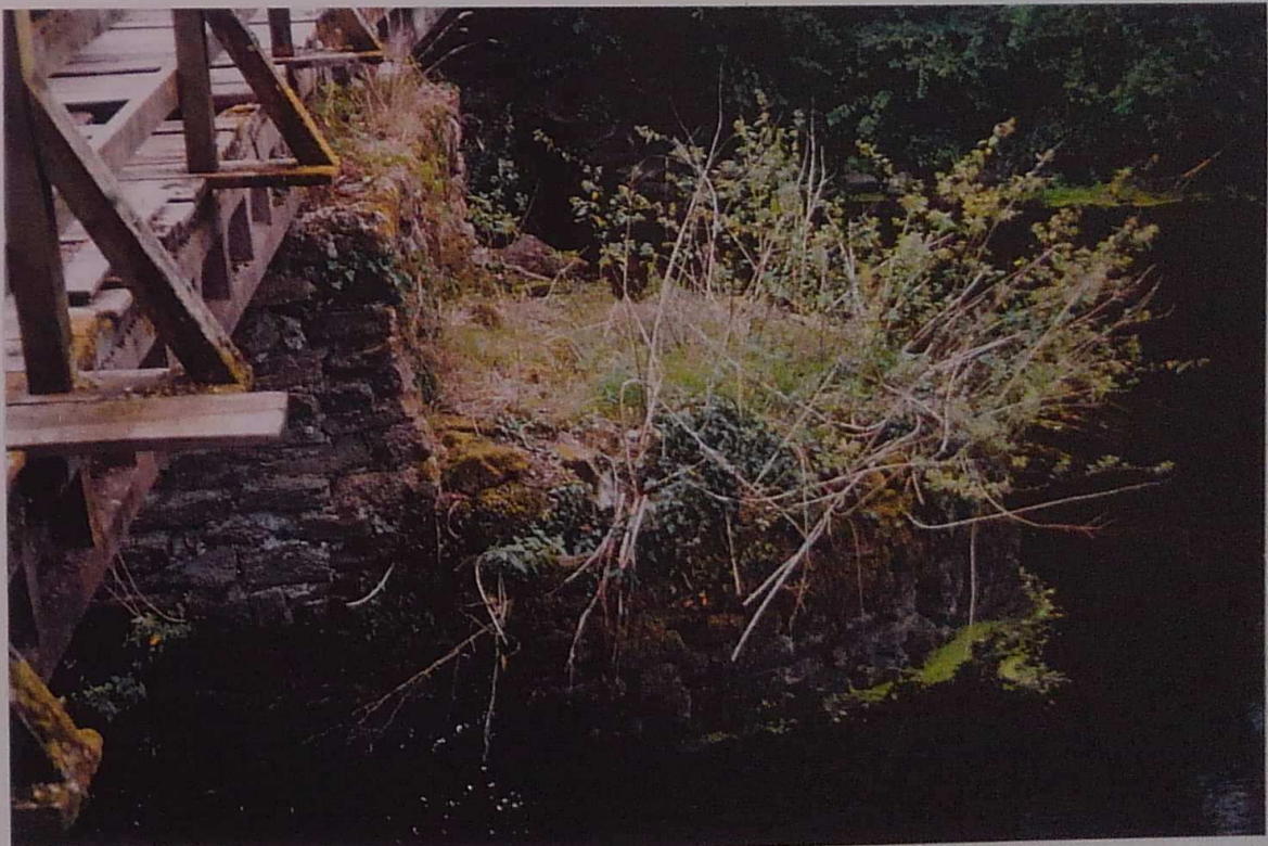
La pile centrale et l'avant-bec amont
