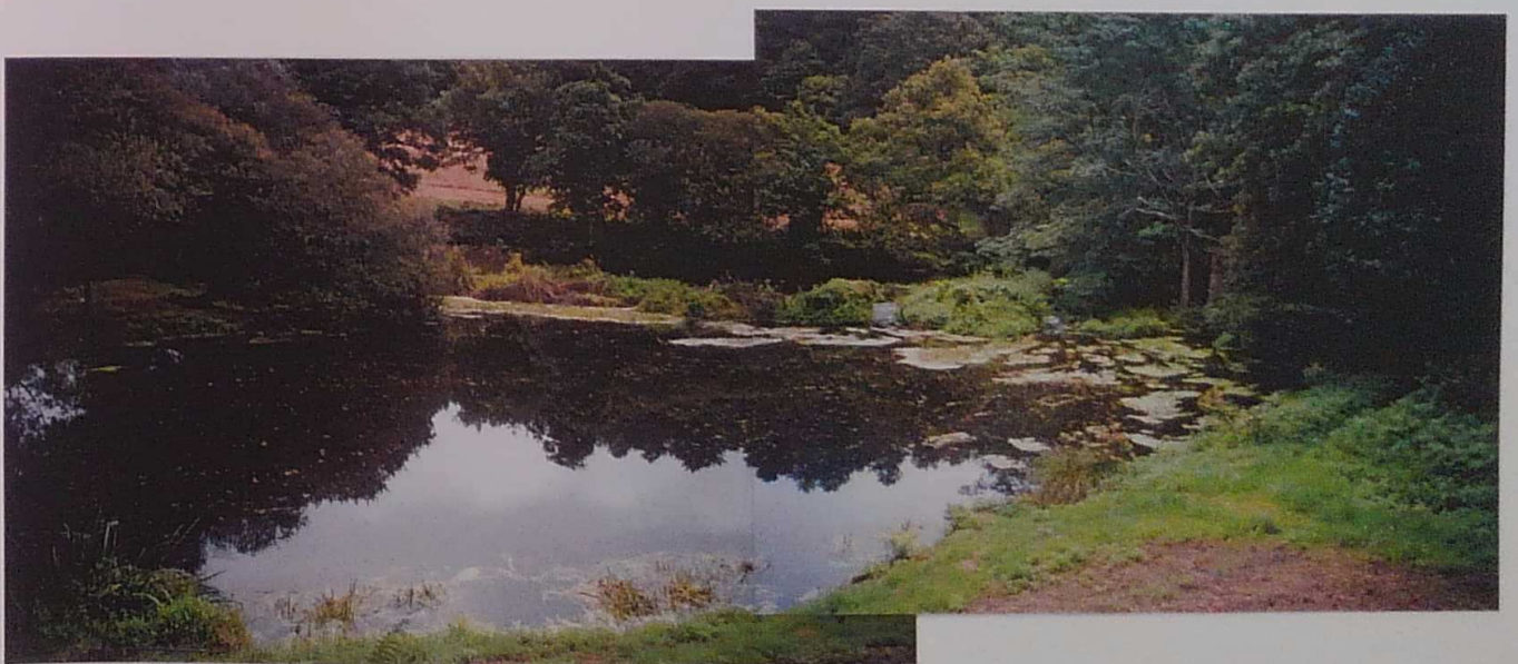
Plan d'eau, déversoir et emplacement de l'ancien vannage
