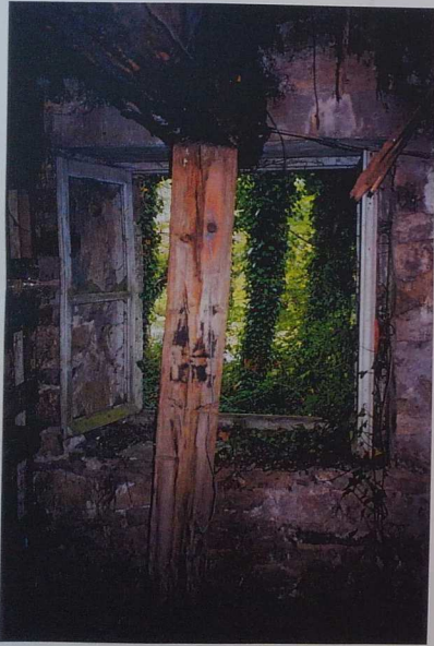
L'intérieur du moulin
