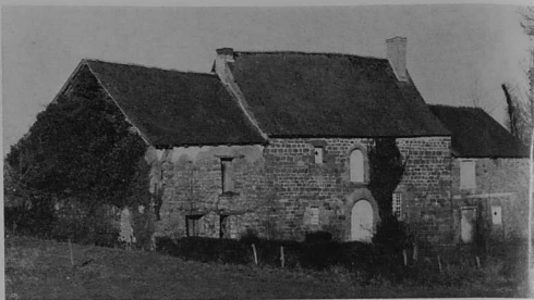
● Ancienne ferme caractéristique des confins de l'Ile-et-Vilaine et des Côtes-du-Nord. (« La Tremblais », à La Baussaine, au nord de Bôcherel).
