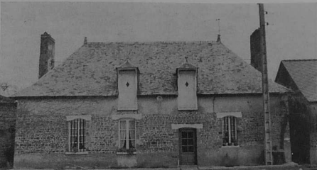
● Schiste et grès sous ardoise « des lacs », linteaux de bois cintrés et blanchis : c'est une ferme caractéristique des environs de Vitré.
