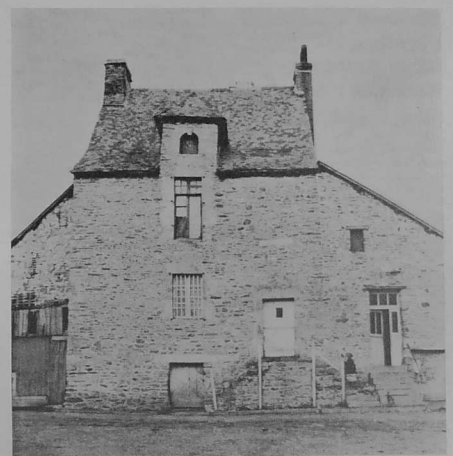
● Mur de schiste, jambages de schiste ou de granite, linteaux de granite... ou de bois : la diversité du sous-sol breton apparaît en résumé dans ce beau bâtiment du XIXe siècle (La Morinière, à l'ouest de Vitré).
