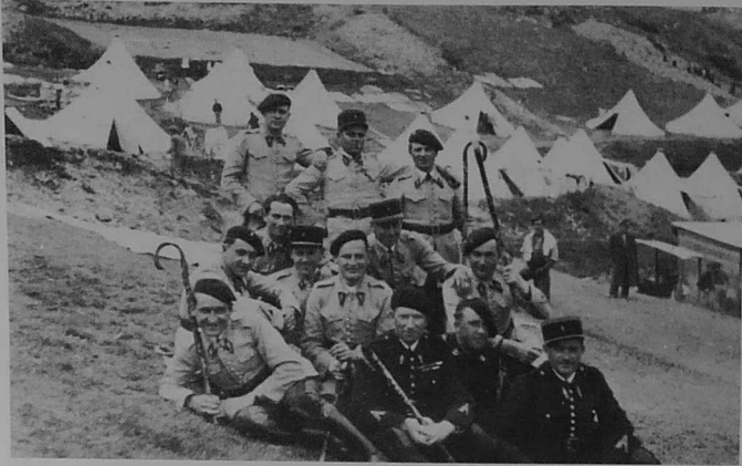
La CONDAMINE Pentecôte 1939 Garde des miliciens des brigades internationales (Espagnols)
