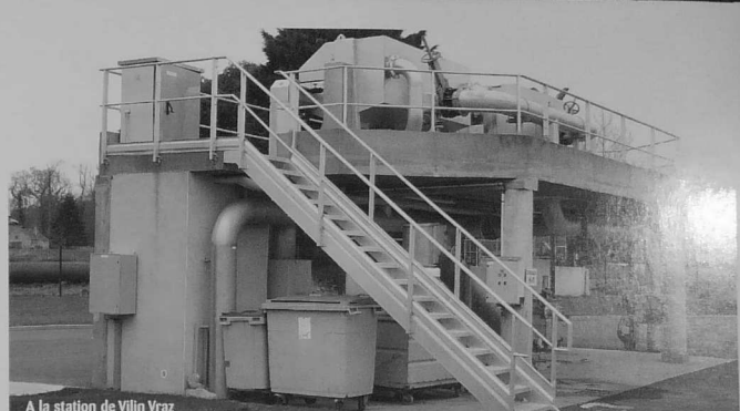
A la station de Vilin Vraz
