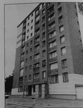
A Maurepas encore, tout près des précédents, un exemple de réhabilitation réussie. 250 MF ont été délogés pour la réhabilitation du patrimoine HLM.
