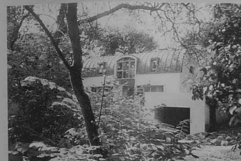
Une réalisation de Marie-Hélène Le Bot, architecte à Brest.
