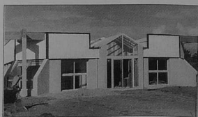
L'atelier-relais construit par la municipalité où s'installera Cosmeceutics
