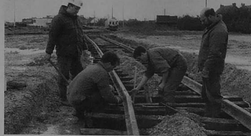
La voie de service relie le dépôt aux voies.
