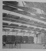
Salle omnisports de Locminé.
