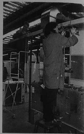
Des élèves du lycée de la Fontaine des Eaux montent une pièce climatisée.
