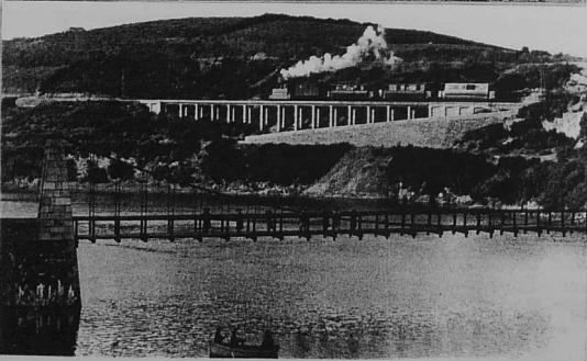
PLOUGUIEL Passerelle et Pont Saint-François
