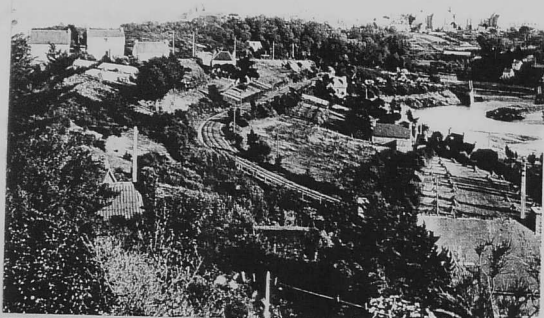
La voie ferrée du petit train qui mène à Lannion entre 1906 et 1949.
