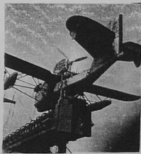
Le "Loire" était un hydravion monoplan, monomoteur, quadriplace de surveillance, catapultable, dont le prototype exécute son 1er vol en 1934.
