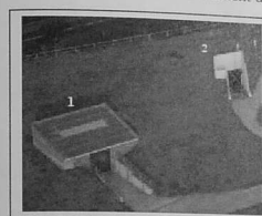
1 Encuvement du radar actuellement couvert 2 Entrée de l'abri pour le groupe électrogène
