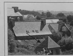
Le toit visible au premier plan a été ajouté à un ouvrage qui abritait le transformateur pour l'alimentation en énergie du radar
