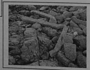
Jambes de trétraèdre en béton dans les rochers de Trestrignel
