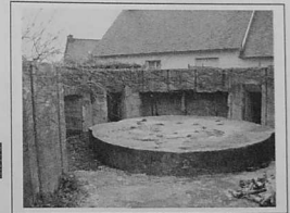
Encuvement du type L 409 a Au centre, l'assise du canon, latéralement les niches à munitions, au premier plan à gauche, les glissières pour fermeture de l'accès permettant l'installation du canon
