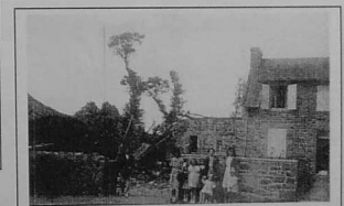
Ferme de Kerbiriou Izellan détruite en 1944
