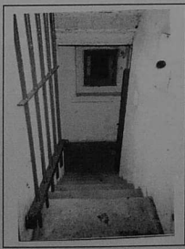
Accès à l'abri avec le créneau de tirs intérieurs prenant le couloir d'entrée en enfilade
