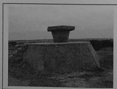
Aspect de l'embase d'un Würzburg Riese situé au-dessus de la Grève-Blanche à Trégastel Sert actuellement de base pour la table d'orientation
