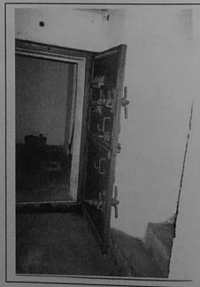
Porte blindée à 2 vantaux permettant en cas d'obstruction du vantail inférieur de sortir par celui du haut
