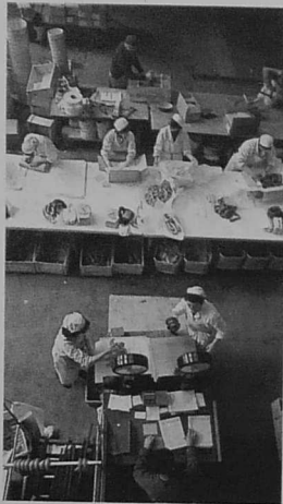
La salle d'emballage des établissements Stalaven
