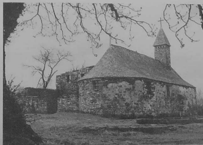
A quelques kilomètres du Val sans Retour et de Tréhorentec: Saint-Jean, Ancien ermitage et chapelle bâtis sur le roc.
