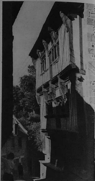
Dinan : le viaduc et une vieille maison. Dinan : the viaduct and an old street. (Cl. G. Goyat).
