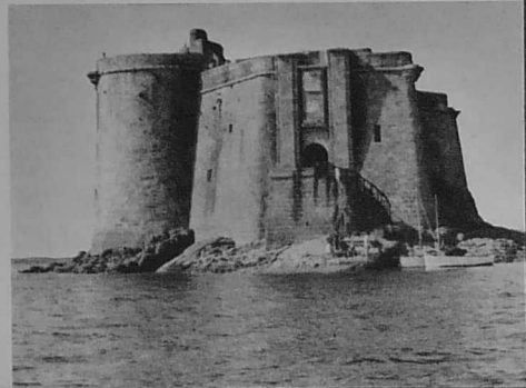
Du haut en bas : Le Poulguin en Névez, sur l'Aven; au premier plan, bassin à huîtres (Cl. Krebs). Le Stang (Cl. Jos Le Doaré). Château du Taureau (Cl. Jos Le Doaré).
