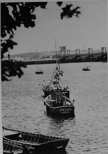
LE BARRAGE D'ARZAL. Une masse de terre et de roches de 500 000 m 3 comprenant une digue de 350 m, une écluse de 85 m sur 13 m, et une centrale d'eau potable, c'est l'imposant barrage d'Arzal. Inauguré en 1972, il est unique en Europe par sa technologie. C'est une immense réserve de 35 millions de mètres cubes d'eau douce et il préserve des inondations toute la région de Redon.
