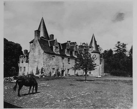
QUISTINIC. La Villeneuve-Jacquelin. « La tour où l'on s'attend à voir flotter parfois La bannière d'azur de quelques belles au bois, L'escalier de granit, le cintre de la porte Toute la poésie antique, simple et forte Des grands toits inclinés vers les horizons bleus. » Claude DERVENN, « Horizons ».
