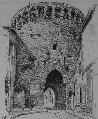
La porte du Jerzual (façade externe).
