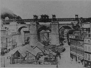
Construction du viaduc (1862).
