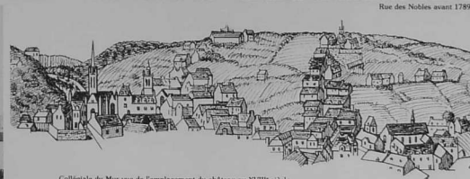
Collégiale du Mur vue de l'emplacement du château au XVIII e siècle.
