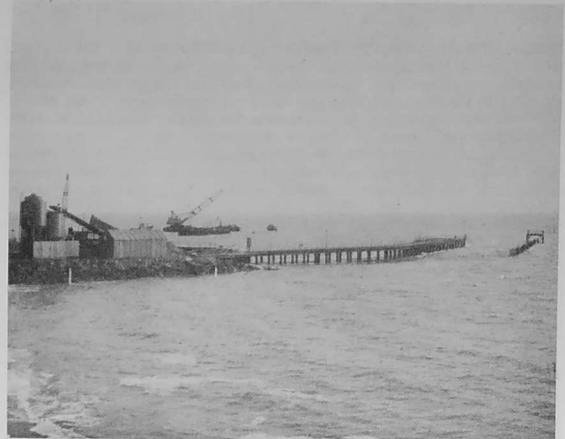
Fig. 3. — L'ancienne jetée de la Noëveillard et, à droite de celle-ci, la digue en construction dont seule émerge la « palissade » (une demi-heure après la pleine mer de coefficient 79, le 12 février 1971 à 17 h. 40).
