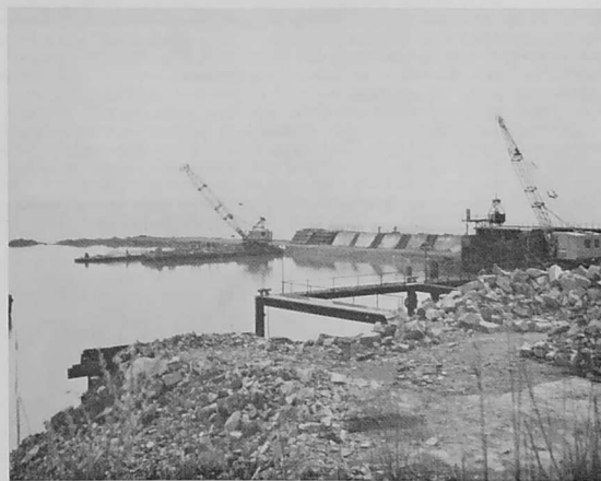
Fig. 5. — La partie orientale du nouveau port à marée basse de coefficient 117, le 27 février 1971 à 12 h. 30. On aperçoit le « ballast », les prismes (ou « plots ») de béton, la « palissade » métallique qui les surmonte actuellement et, au premier plan, l'amorce du terre-plein nord.
