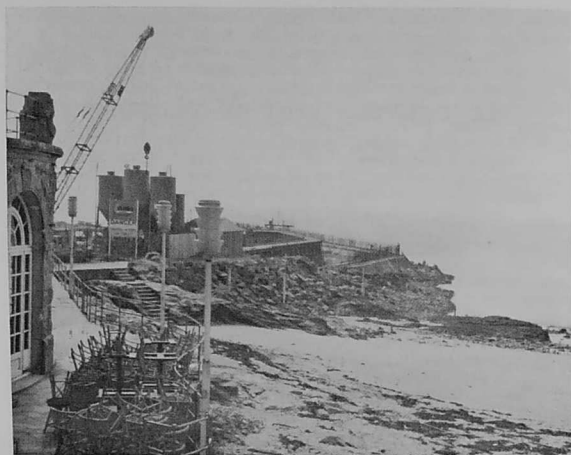
Fig. 1. — Le chantier, en mars 1971, vu de l'angle NE de la plage de la Noëveillard. Au centre, l'ancienne jetée. A droite de celle-ci, l'amorce de la nouvelle digue.
