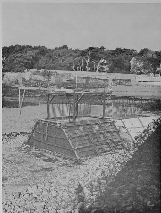
Fig. 2. — Au premier plan, le « ballast » de blocs de leptynite et le coffrage en forme de prisme ; à droite de celui-ci, le soubassement trapézoïdal décoffré ; « palissade » de tiges d'acier. Au second plan, l'estran rocheux et l'extrémité ouest de la plage de la Noëveillard. Au troisième plan, les parcs des villas (février 1971).
