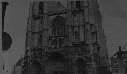
Le temps des cathédrales. Ici la cathédrale St-Pierre à Nantes construite à partir de 1434 en pierre tendre grise. La charpente en bois a été incendiée en 1972 et remplacée par une armature en béton.
