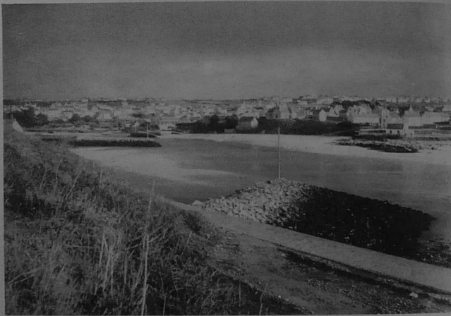
L'entrée du port d'Audierne - les deux nouveaux épis sont visibles ainsi que Poulgoazec.
