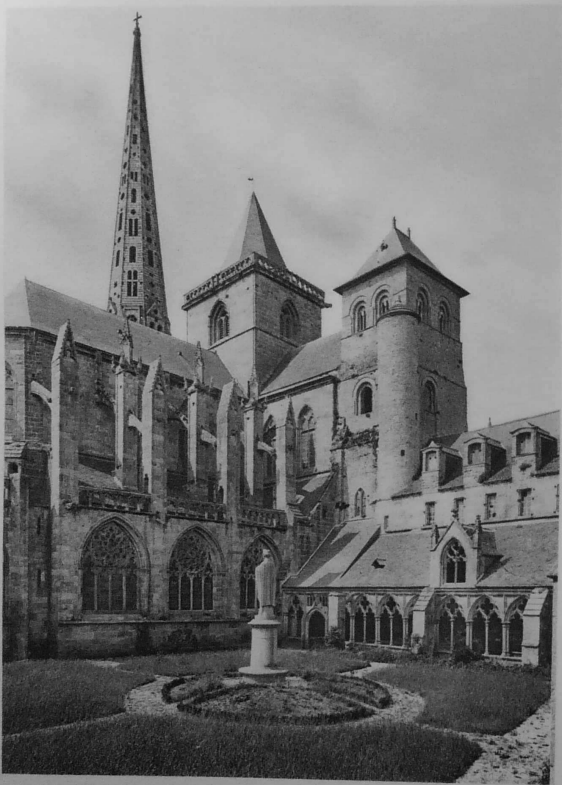
TRÉGUIER. — ANCIENNE CATHÉDRALE. — Le cloître, xv e s. À gauche, fenêtres ogivales à rosaces de pierre; à droite, les arcades et leurs fines colonnettes. La tour d' Hodins , construite au xii e s., possède des fenêtres romanes; derrière, la tour du Sanctus , style ogival, a un balcon ajouré. Au milieu de la pelouse, la statue de saint Yves.
