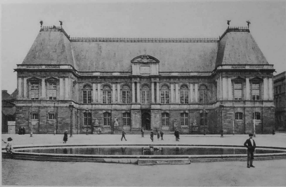
RENNES. — LE PALAIS DE JUSTICE. — Ancien Parlement de Bretagne. Commencé en 1618 sur les plans de Salomon de Brosse et terminé par Corméau et Laurent Magnier en 1654. Style toscan, Louis XIII. Façade de 48 mètres de largeur. Statues de D'Argentré, La Chaulais, Tuallier et Gerbière .
