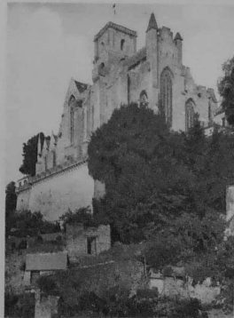
LAMBALLE. — Église Notre-Dame. — Vue du sud-ouest.
