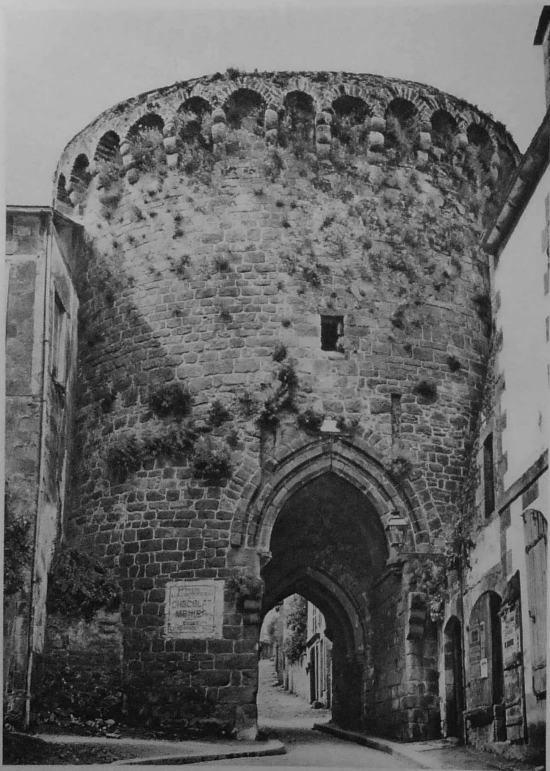
DINAN. — LA PORTE DU JERSUAL. — XIV e s. Vestiges de l'ancien pont-levis. Architecture féodale.
