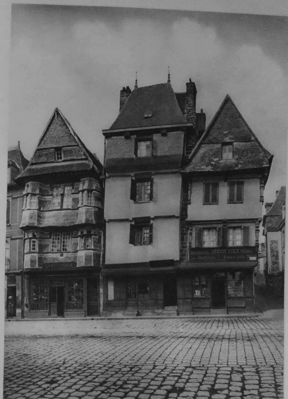
LANNION — Anciennes maisons du xvi e s. Celle de gauche a deux étages à auvent et deux encorbellements, le tout revêtu d'ardoises. On voit encore les consoles de bois de celle de droite entièrement restaurée.
