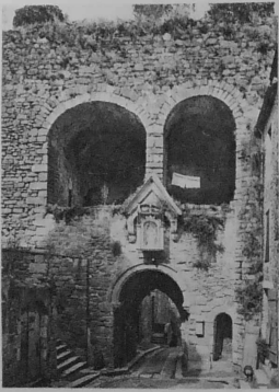
DINAN. — LA PORTE DU JERRUAL. Aspect intérieur.
