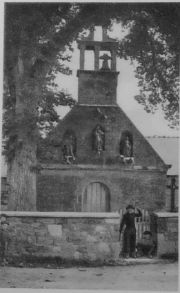
PAIMPOL. — LA CHAPELLE DE PERRON-HAMON. — On voit sous le porche le Mur des disparus en mer .
