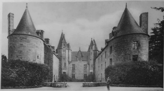
KERGRIST. — Le CHATEAU. — Construction du xv e s., remaniée ultérieurement.
