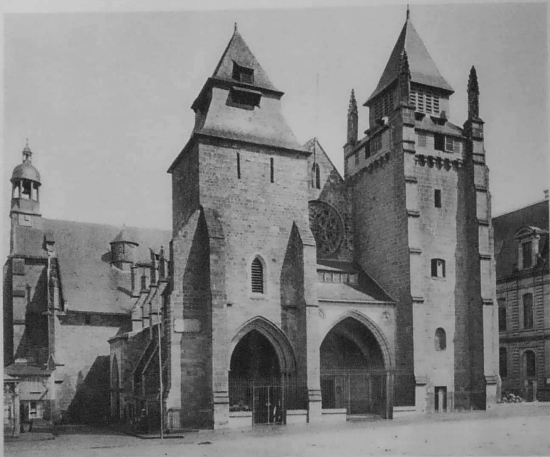
SAINT-BRIEUC. — CATHÉDRALE SAINT-ÉTIENNE. — Eglise fortifiée au XIII e s. A subi deux sièges, 1375-1394. Entièrement restaurée. La tour de droite est couronnée de mâchicoulis, celle de gauche a conservé ses meurtrières. Style ogival.
