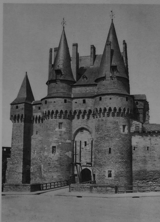
VITRÉ. — Le Château. — Porte d'entrée flanquée de deux tours rondes. Arc ogival à consoles historiées surmontant le pont levés. Chemin de ronde à mâchicoulis gothiques et toitures coniques. A gauche, tour carrée plus réduite au sommet qu'à la base. L'ensemble est appelé Le Châtelet .
