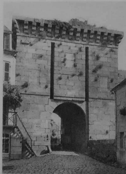
DINAN. — LA PORTE SAINT-LOUIS. — Fin xv e s., datée 1620. Le logement des bras de l'ancien pont-levis subsiste.
