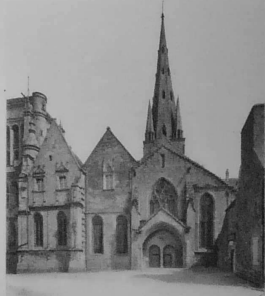
GUINGAMP. — NOTRE-DAME-DE-BON-SECOURS. — Arrière-face. Style gothique et Renaissance. Clocher de pierre, hauteur 60 m., répliqué par 4 clochetons.
