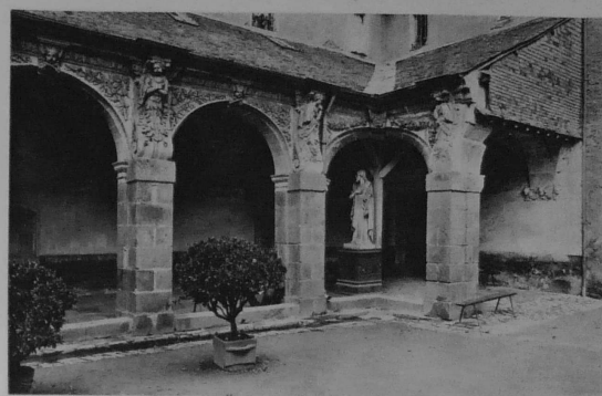
RENNES. — ÉGLISE SAINT-MELAINE. — Cours de l'ancien monastère. Piliers romans et arcades enjolivées d'une décoration du xiii e s.
