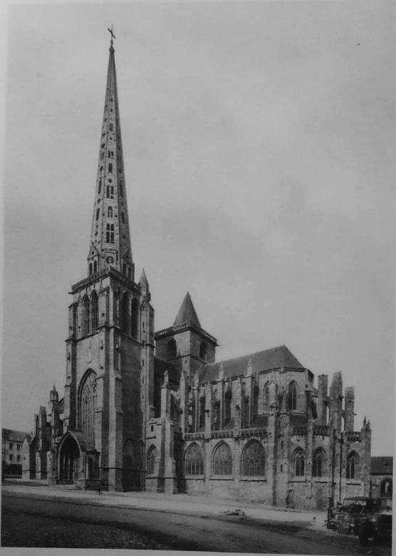
TRÉGUIER. — ANCIENNE CATHÉDRALE. — Fondée au ix e s., puis dévastée, elle fut restaurée en 1296 et reconstruite en 1539. Style gothique et flamboyant. Clocher en pierre ajourée du xviii e s., la tour datant du xv e s., hauteur : 65 m.
