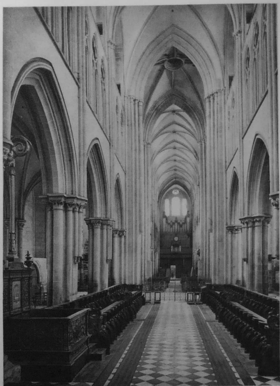
DOL. — SAINT-SAMSON. — La nef, longueur 100 mètres, comprend 13 travées formées de piliers, composés d'une grosse colonne et 4 colonnettes, reliées par des arcades gothiques que surmonte un triforium ou galerie à jour.
