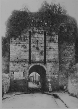
DINAN. — LA PORTE SAINT-MALO. — Couronnée de mûchicoulis. De chaque côté, les anciens remparts.
