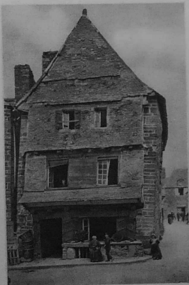
CARHAIX. — PLACE DE LA MAIRIE. — Ancienne maison du xv e s. Façade et auvent en ardoises.
