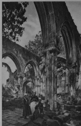
LAMBOURG. — RUINES DE L'ANCIENNE EGLISE DE LAMBOURG. — xv e s. Arcades ogivales, tailloirs sculptés.
