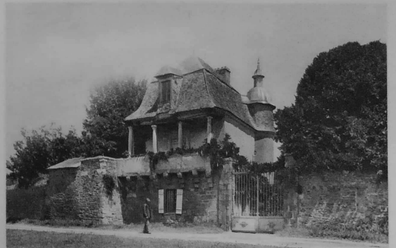
HENNEBONT. — ABBAYE CISTERCIENNE DE LA JUIE. — 1252. Fondée par Blanche de Champagne, femme du Duc Jean I er le Roux. Transformée au XVI e s.; les bâtiments conventuels sont modernes.
