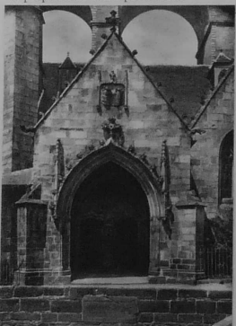
MORLAIX. — EGLISE SAINT-MELAINE. — Porche latéral. Belle ogive flamboyante. À l'intérieur, porte double et fresques peintes.
