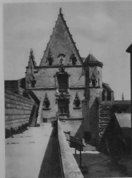
NANTES. — LE CHÂTEAU. — La chapelle. Style gothique.
