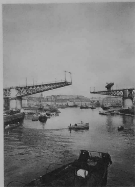
BREST. — LE PONT TOURNANT. — Conçu en 1859 par M. Alph. Oudry, et exécuté par les ateliers du Creusot en 1861. Longueur totale, 257 m., longueur des volées, 52 m. 85.
