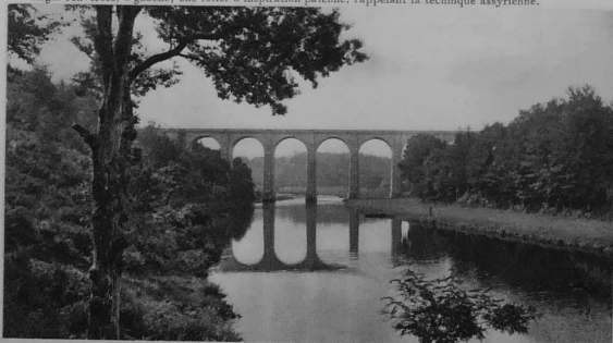
QUIMPERLÉ. — LA LAÏTA ET LE VIADUC.
