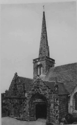
LA MARTYRE. — Eglise. — Porche latéral, style flamboyant. À gauche, chapelle du xvii e s. Armes des Rohan.
