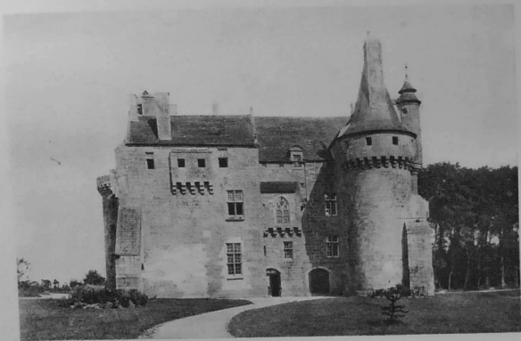
KÉROUZÉRE. — LE CHÂTEAU. — 1458. Restauré en 1602. Chemin de ronde à mâchicoulis et bretèches. La fenêtre, en gothique flamboyant, éclaire une chapelle construite à la fin du xv e s.
