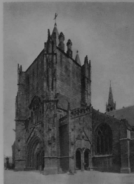
PENMARCH. — Eglise SAINT-NONNA. — Tour occidentale, xvi e s., rampe ajoutée de l'escalier du clocher.
