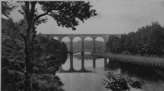
QUIMPERLÉ. — LA LAÏTA ET LE VIADUC.
