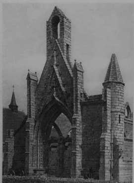
BOURG-DE-BATZ. — Ruines de la Chapelle du Muer. — xv e s. Style gothique. Fondée par Pierre de Rieux à son retour de captivité, 1419.
