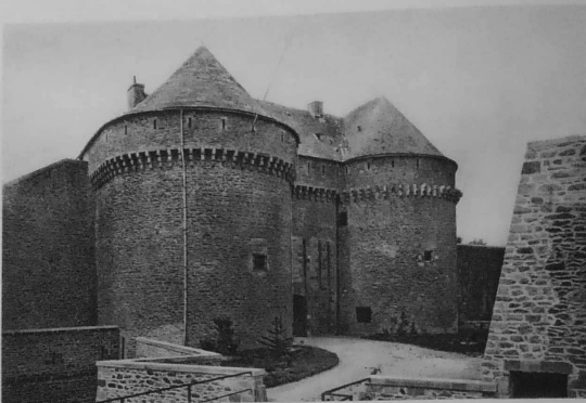
BREST. — Le CHATEAU. — Porte principale. Tours semi-circulaires avec couronnement de mâchicoulis.
