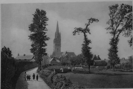
PLOARÉ. — Eglise. — xv e s., style gothique flamboyant. Clocher, hauteur, 55 m., l'un des plus beaux de la Bretagne.
