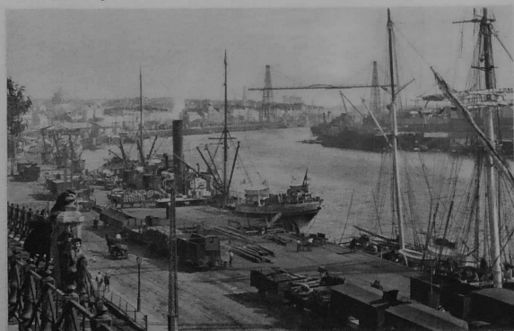
NANTES. — PRINCIPALE VILLE DE BRETAGNE. — Fondation romaine. 18 ponts sur la Loire. Centre industriel et commerçant. Port maritime et port fluvial. Le pont transbordeur, dont le tablier a 191 m. de longueur et 50 m. de hauteur au-dessus de la Loire, a été construit en 1903.
