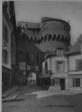
VANNES. — LA PORTE PAISON. — Vestige des anciens remparts. Superstructure sur le couronnement de machicoulis.
