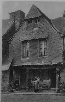
GOURIN. — Maison du xvi e s., revêtue d'ardoises.
