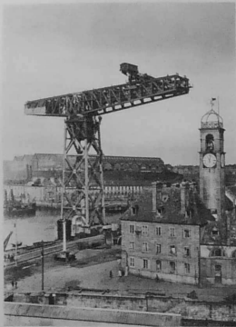
BREST. — LE PONT TOURNANT. — Conçu en 1859 par M. Alph. Oudry, et exécuté par les ateliers du Creusot en 1861. Longueur totale, 257 m., longueur des volées, 52 m. 85.
