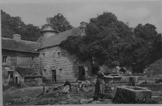
SAINT-HERBOT. — Ancien château de Russec, converti en ferme.
