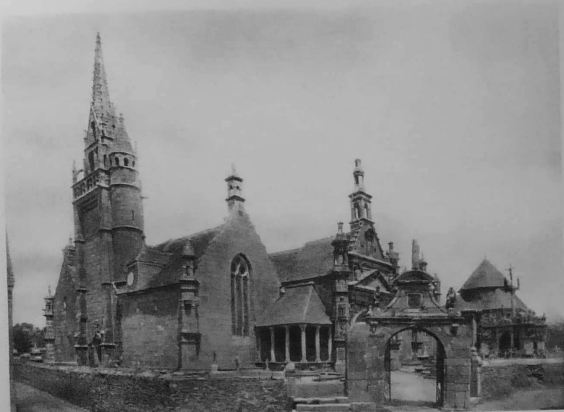
GUIMILIAU. — ÉGLISE ET ARC DE TRIOMPHE. — Clocher à flèche aiguë (gothique). Clochetons et transept de la Renaissance. Fenêtres style flamboyant, 1602.
