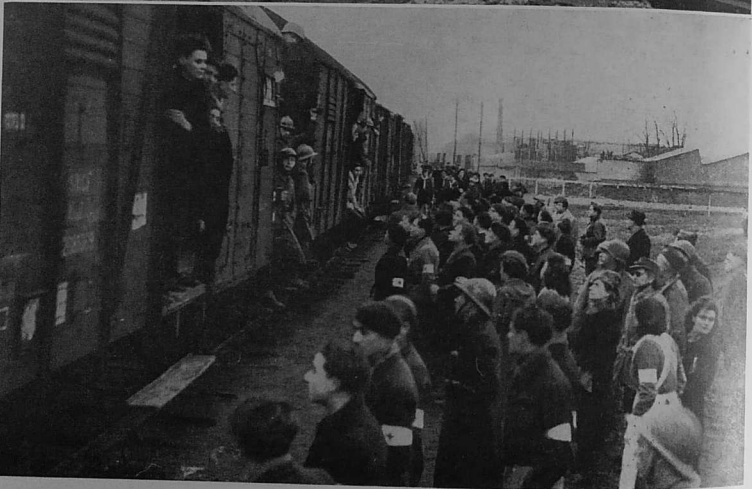
En haut. — A la station de Cordemais, officiers Américains et Allemands font reposer les rails pour permettre le passage des trains évacuant 13.000 civils de la poche de Saint-Nazaire (17 janvier 1945) En bas. — Arrivée à Nantes d'un train avec 700 habitants de Saint-Nazaire, où ils sont recueillis par
