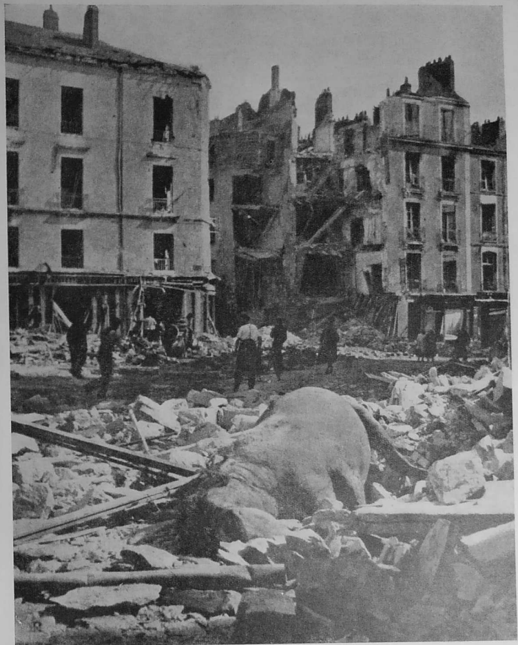
Les travaux de déblaiement après le bombardement de la place de Bretagne
