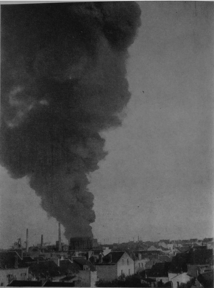
Incendies à Saint-Nazaire, juin 1940. Les réservoirs de pétrole en flammes
