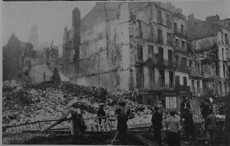
Septembre 1943. — Sur les quais de Nantes. Travaux de sauvetage après un bombardement
