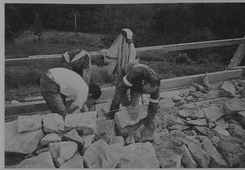
Chantier spectacle : la restauration des remparts à la mode du XI e siècle
