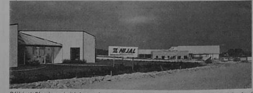
Déjà installés à proximité du nouel routier, l'entreprise Nijal et la conserverie Le Floch l'au fond en cours de construction.
