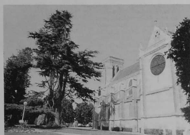
L'église Saint-Joseph, en cours de rénovation.
