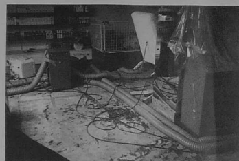
10 heures après le sinistre, le matériel de séchage et de nettoyage est en marche dans la parfumerie. La garantie pertes d'exploitation est aussi une assurance "volocata".
