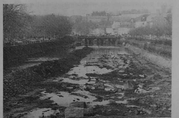
Le chantier en janvier
