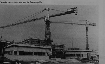
L'année des chantiers sur le Technopôle
