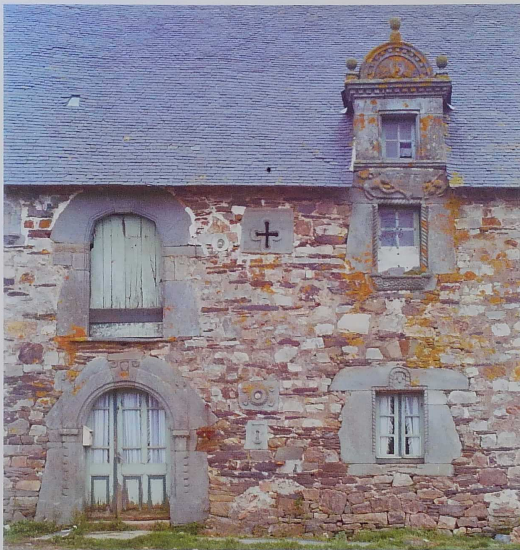
Schiste et grès pour une façade multicolore, 1728 (Mur-de-Bretagne, Côtes-d'Armor, état en 1977)
