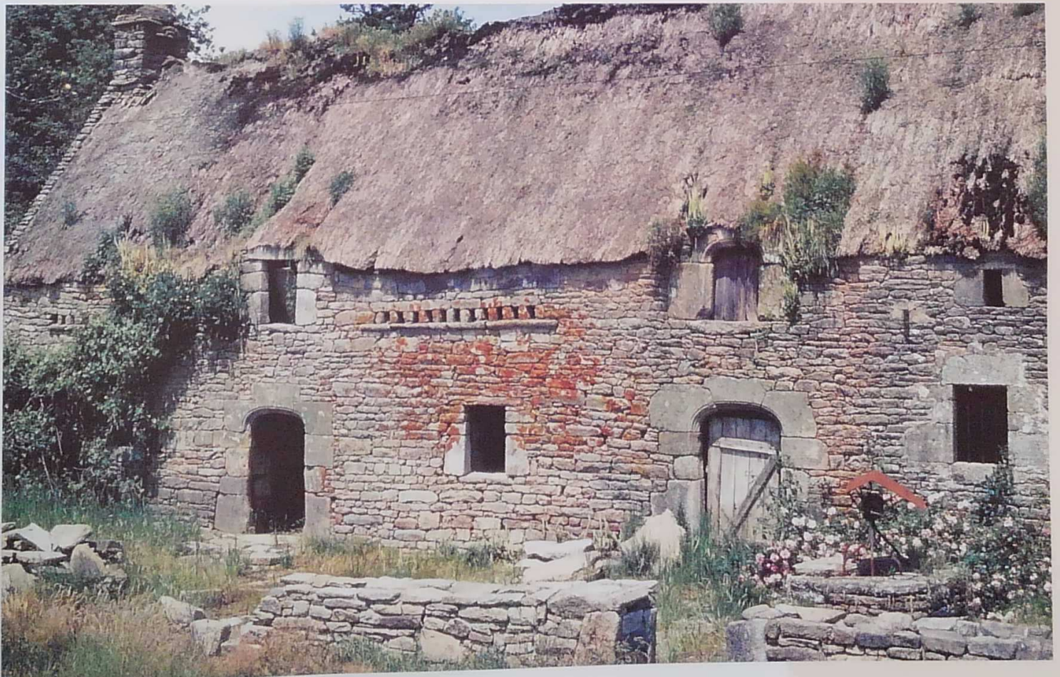
Appareil en moellon équarri de granite, encadrement des baies en pierre de taille. 17 e -18 e siècle (Baudry, Morbihan)
