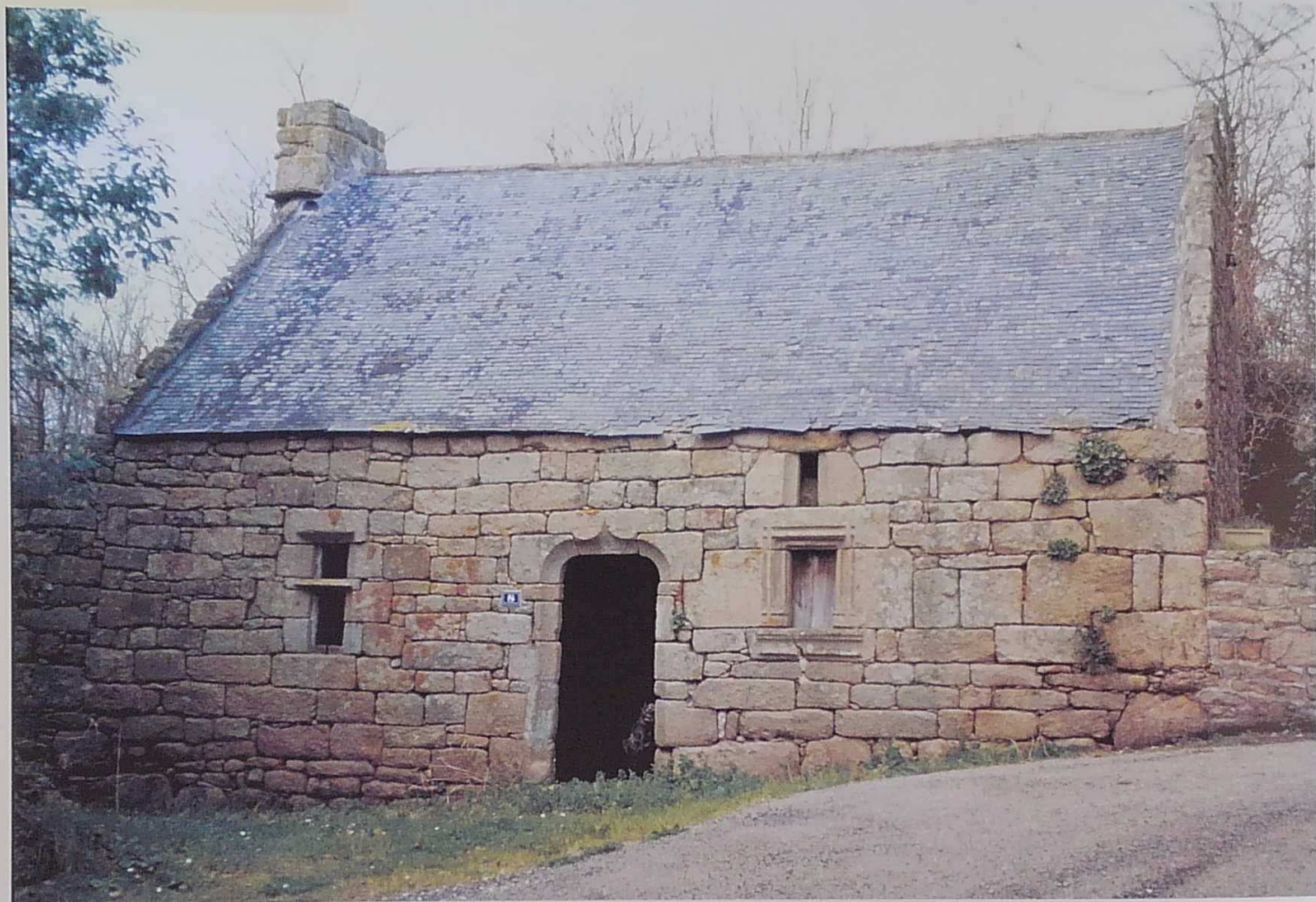
Entre moellon équarri et pierre de taille - le granite pose à sec ou calé de plaques d'ardoise. 17 e siècle (Esquibien, Finistère)
