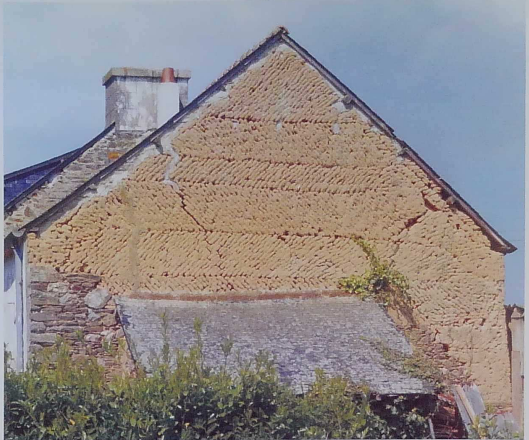
Pignon construit en briques de terre posées en chevrons, 19 e siècle (Saint-Barnabé, Côtes-d'Armor).
