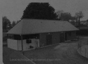
Local technique de la station d'épuration
