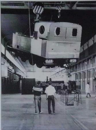
Quand une locomotive plane... C'est cool ! Le châssis et les superstructures rejoignent la chaudière à EdF à Saint-Denis. Photo : H. Dupuis
