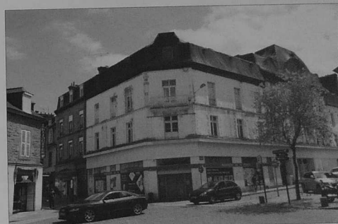
L'état du bâtiment ne permettant pas une réhabilitation, le Crédit Agricole va démolir et veillera à ce que le projet s'intègre bien dans son environnement.
