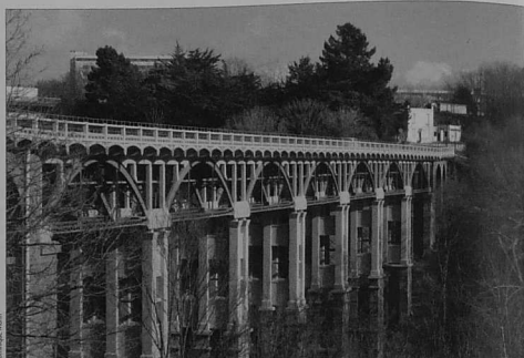
Le viaduc de Toupin arbore à nouveau ses couleurs d'origine.
