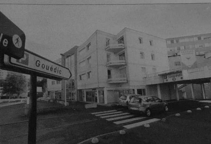
L'entrée et la sortie des véhicules se font exclusivement par la rue de Gouédic.
