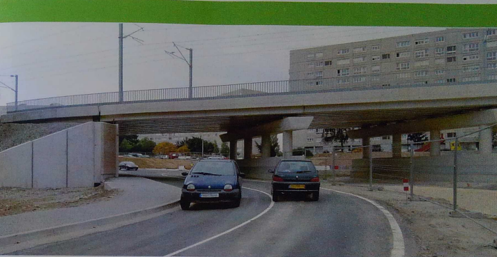
Le nouveau pont construit sous la voie ferrée.
