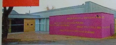
Le radar du Pin-Sec a fait l'objet d'une reconstruction lourde.
