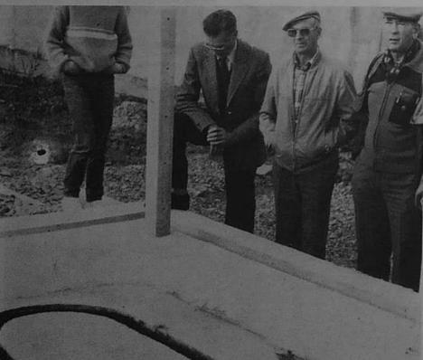
Le second composteur en cours de réalisation. L'une des failles du projet Bertin, le serpent de chauffage se dilate plus vite que le ciment.
