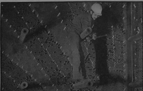
Tubage d'un condenseur de centrale nucléaire (photo D.R.)
