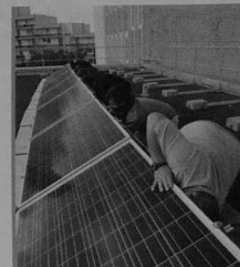
Fabrication et installation « maison ».
