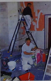
Opération de rénovation avec réaménagement de bureaux à l'Hôtel de Ville.
