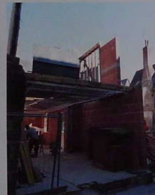
Les travaux de reconstruction se poursuivent rue Baudrairie.
