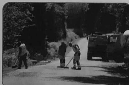
Juillet : travaux route de la Chapelle
