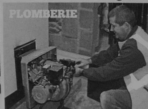
Hugues Garnier, plombier, s'occupe de la maintenance des chaudières communales et des installations de plomberie.
