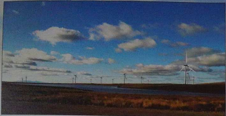
Ferme éolienne sur l'île d'Arran, en Ecosse.
