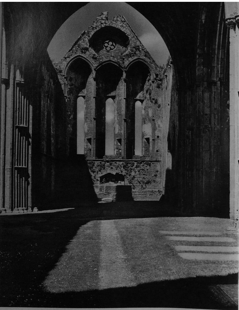
Blick in das Querschiff der Kathedrale von Cashel mit seinen für das 13. Jh. charakteristischen Lanzettfenstern Photo Josef Jetter
