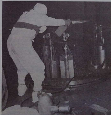
Phénix : intervention sur les échangeurs intermédiaires. (D.R.)
