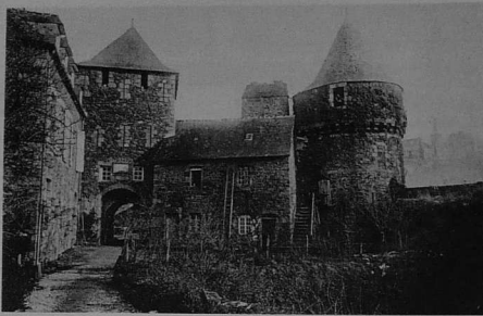
Entrée du château au début du siècle avant la restauration. Le bâtiment sur le rempart est un vestige des logis édifiés à l'époque moderne.
