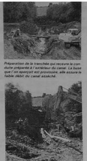
Préparation de la tranchée qui recevra le conduit préparé à l'extérieur du canal. La buse que l'on aperçoit est provisoire, elle assure le faible débit du canal asséché.
