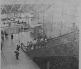
La première tranche des travaux a été livrée fin mai. La galerie marchande ne devrait plus tarder à ouvrir. Pour le reste, il faudra attendre juin 1992. Le reste, c'est le nouveau buffet de la gare et surtout (gras morceau) l'interconnexion avec le Val. Le coût global des travaux s'élève à 400 MF (200 MF de la SNCF et 200 MF de la ville, avec participation de l'Etat, la Région, le Département, la Chambre de Commerce et d'Industrie). ■
