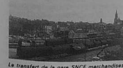
Le transfert de la gare SNCF marchandises permettra au centre de récupérer un formidable espace.
