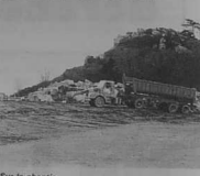
Sur le chantier
