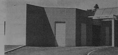
L'unité de scanographie, située avenue des Otages, est un service à la disposition de la population de la Bretagne intérieure. Il offre aux patients de ce secteur de longs délais de soins. Scanographie de dernière génération, il est utilisé en étroite collaboration par le secteur hospitalier et libéral. L'intéressé assis au scanographie réside dans une plus grande flexibilité d'adaptation du corps humain permettant un diagnostic fiable et précoce. L'examen est de plus totalement indolore.
