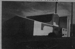
Usine d'incinération de Montauban (82) - Récupération de chaleur - Scarabée d'Or 1986
