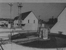
La station des eaux
